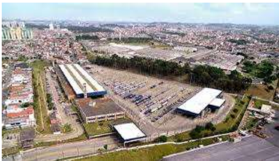
CECOM - Centro de Controle Operacional e de Manutenção em São Bernardo do Campo/SP
