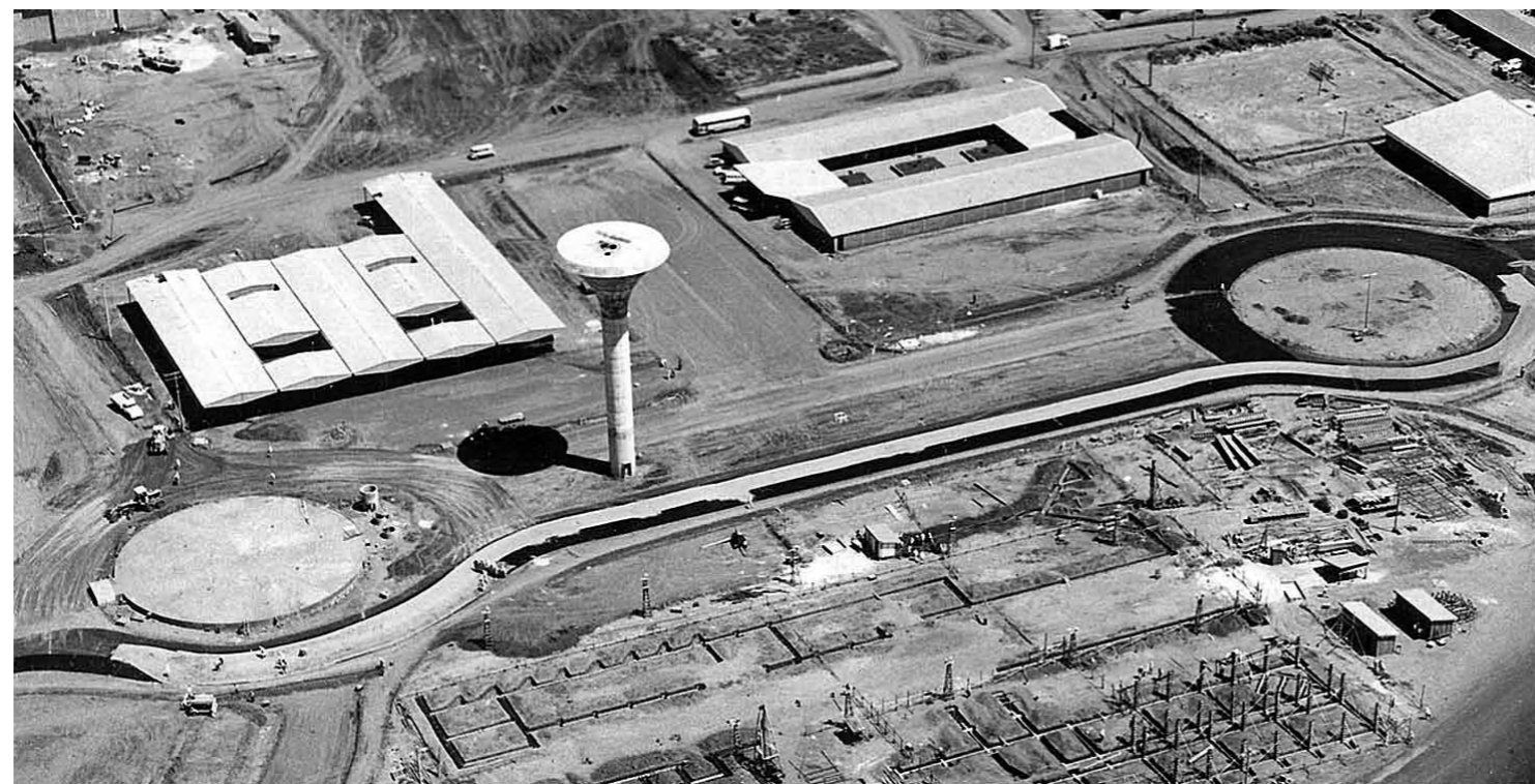
Brasília em construção, 1958.
