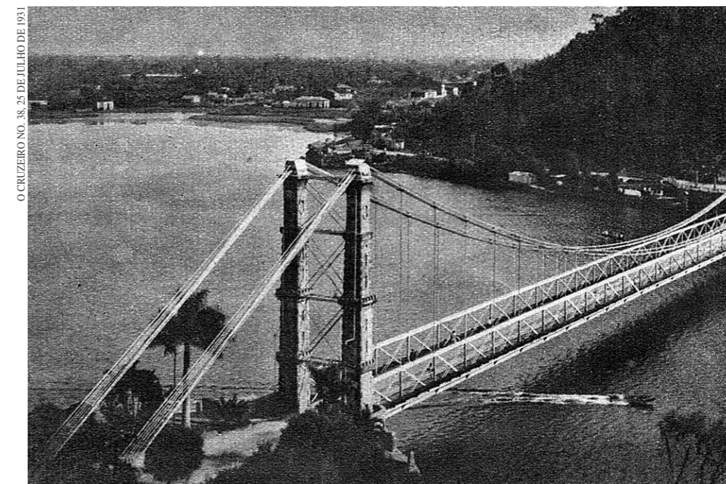
Ponte pênsil de São Vicente, SP, construída em 1914, com vão livre de 180 metros. A obra integra uma série de iniciativas de saneamento e transportes, projetada pelo engenheiro Saturnino de Brito.
