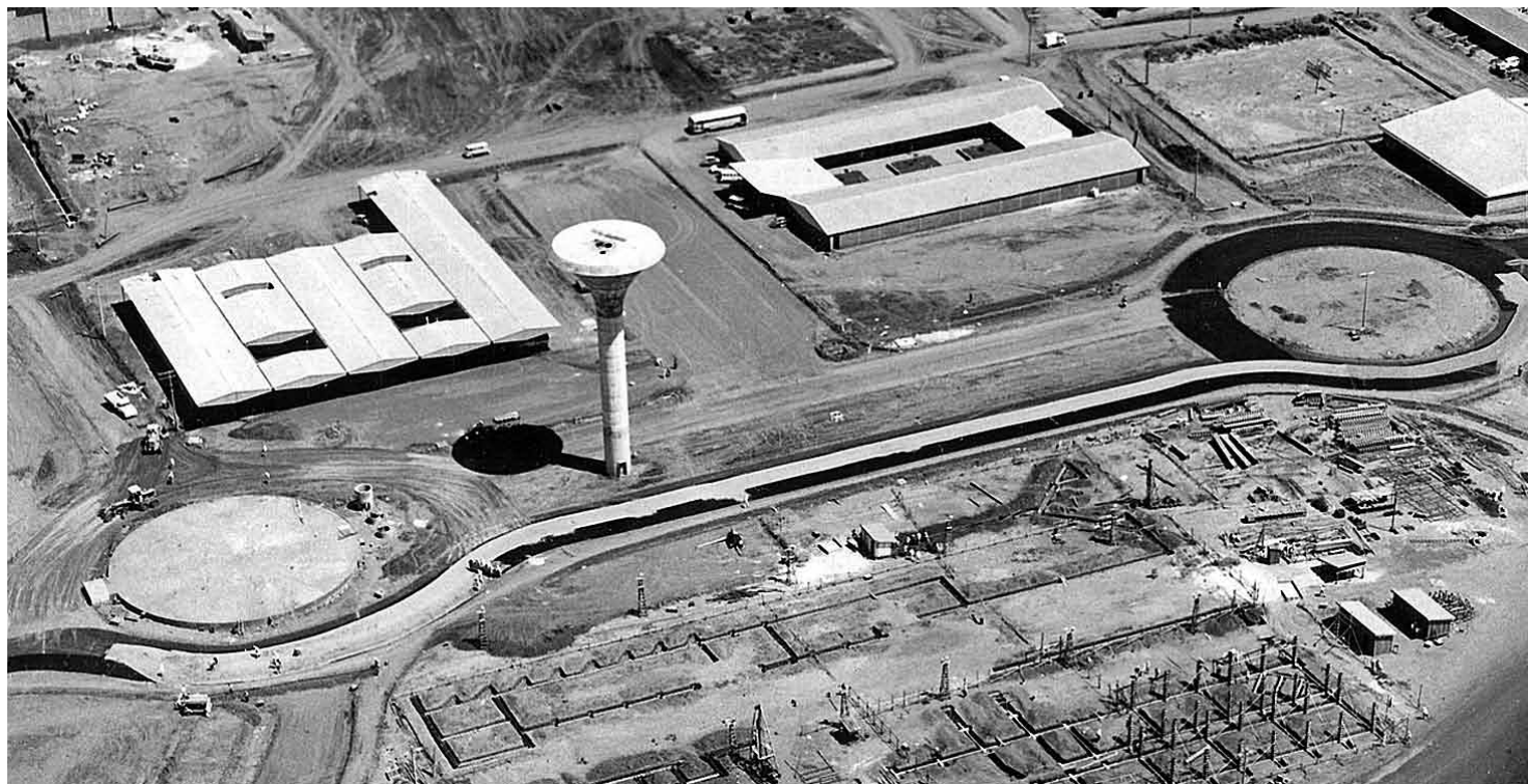
Brasília em construção, 1958.
