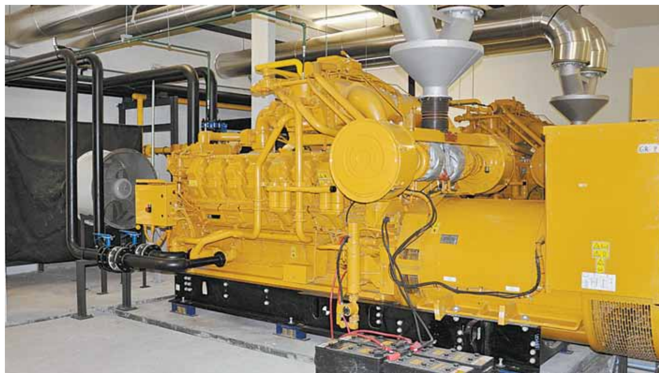
Cogeração composta com motogerador a gás natural.
