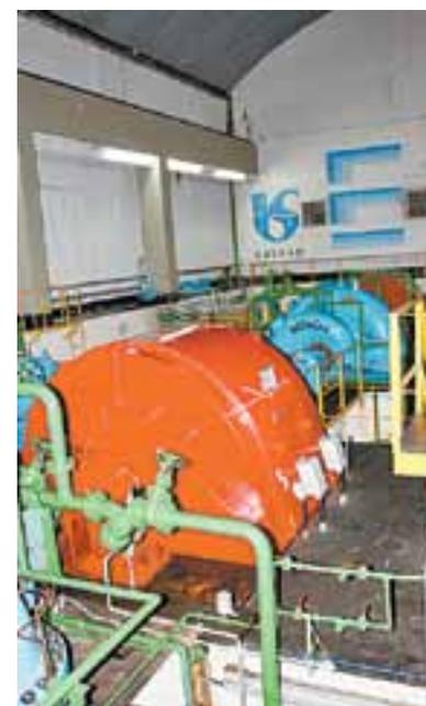
Casa de máquinas da Estação Elevatória Santa Inês: motobombas instaladas a 60m da superfície.
