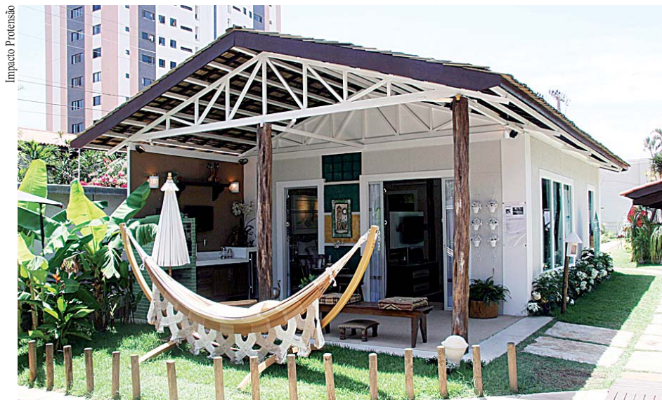
Protótipo da casa feita de plástico reciclado que está em fase de testes na Universidade Federal do Ceará. São 45m 2 , com estrutura metálica, custo de R$ 18 mil e prazo de dois dias para montagem.
