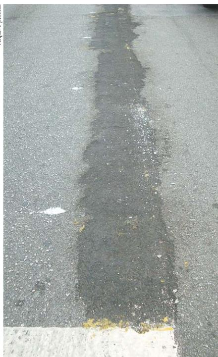
Asfalto danificado pela retirada de sinalização.
