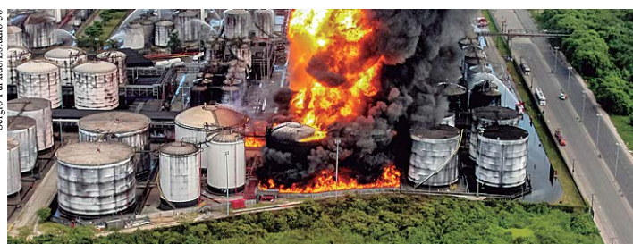
Incêndio atinge tanques em terminal de combustível da Ultracargo.
