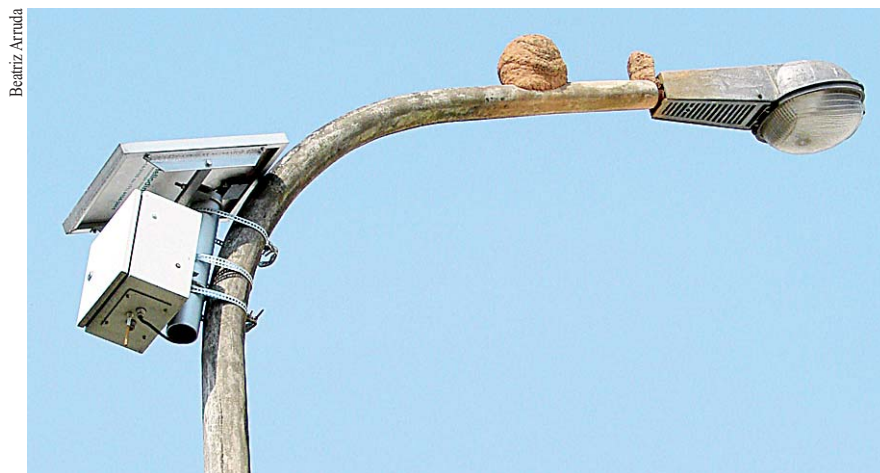
Composto por roteador, painel solar, baterias e controlador de energia, o equipamento tem fácil instalação e pode ser colocado em postes ou paredes.
