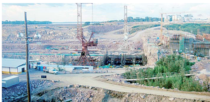
Obras de Jirau, que custará R$ 10 bilhões e começará a gerar energia em 2012.
