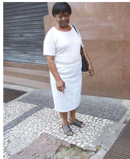
Etelvina Silva aponta irregularidades na calçada do Viaduto Dona Paulina, no Centro de São Paulo.
