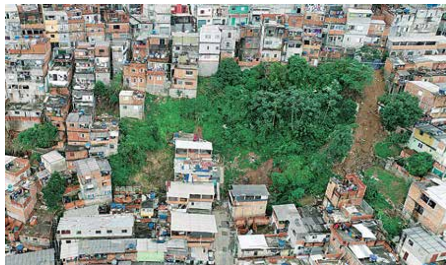
Área de risco em encosta de morro, na região do Jaçanã, zona norte da Capital.
