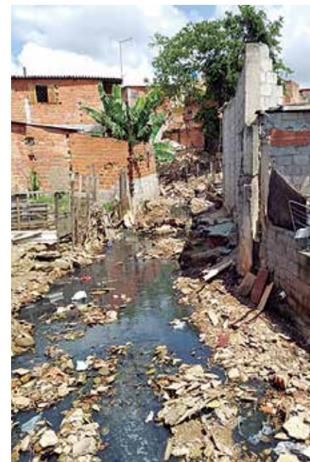
Moradias construídas na beira do Córrego São João, no Itaim Paulista.
