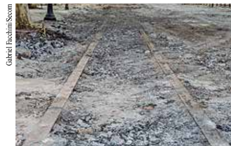
Trilhos expostos durante as obras no Anhangabaú.
