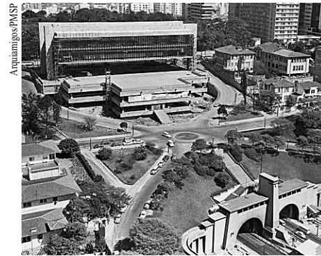
Vista aérea da construção do Masp.
