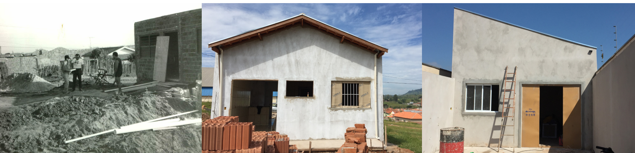
Obras realizadas pelo Promore.
