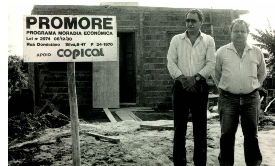
Marcos Wanderley Ferreira e Rutênio Gurgel Bastos posam em uma casa construída sob a orientação do Promore.
